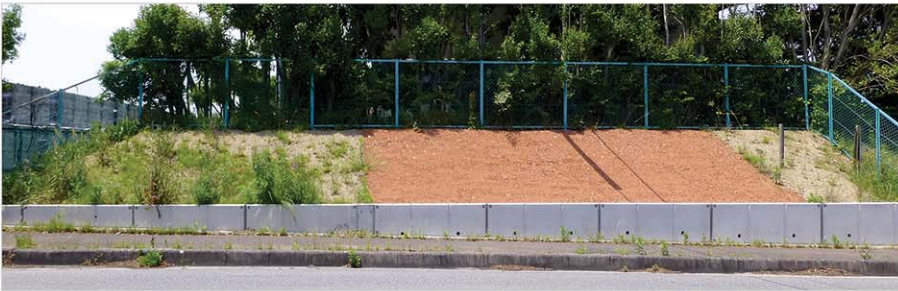
擁壁の裏込材・防草材(法面部分)
