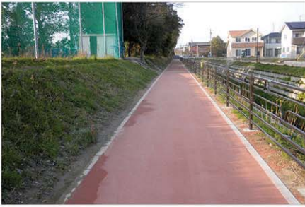
舗装材(固化材を用いた歩道)
