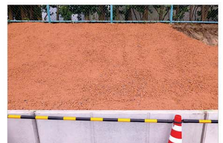
擁壁の裏込材
