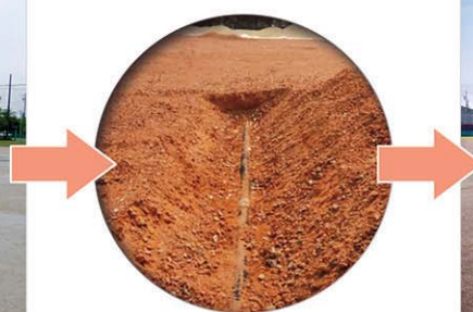
排水管を併称した水はけ対策
