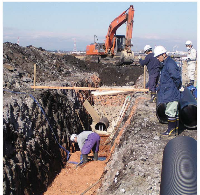
暗渠の埋戻材(埋立地)
