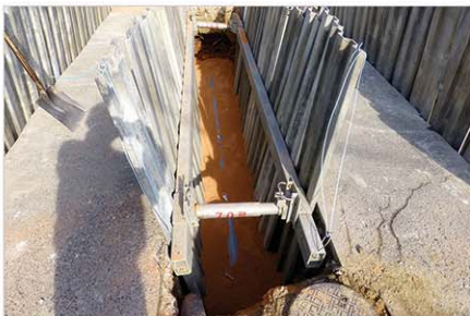
埋設管の埋戻実験
